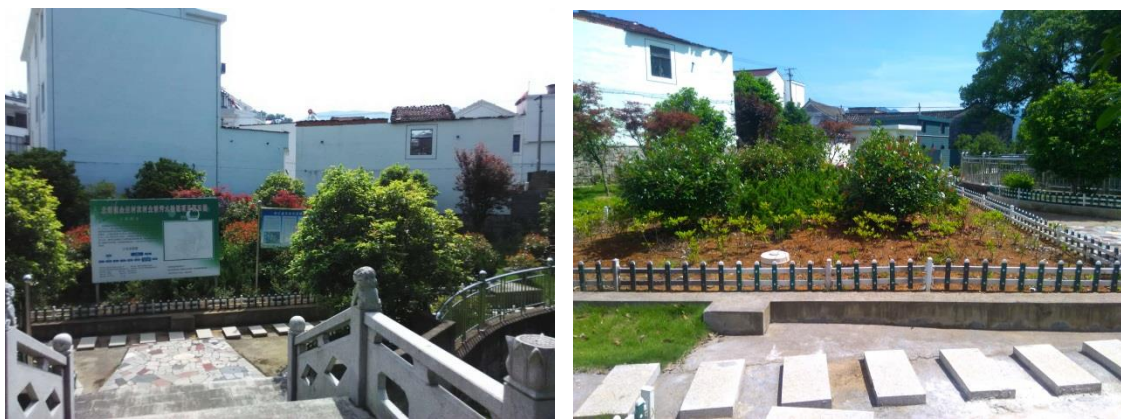
图 5-4 金兰村生活污水处理设施实景
