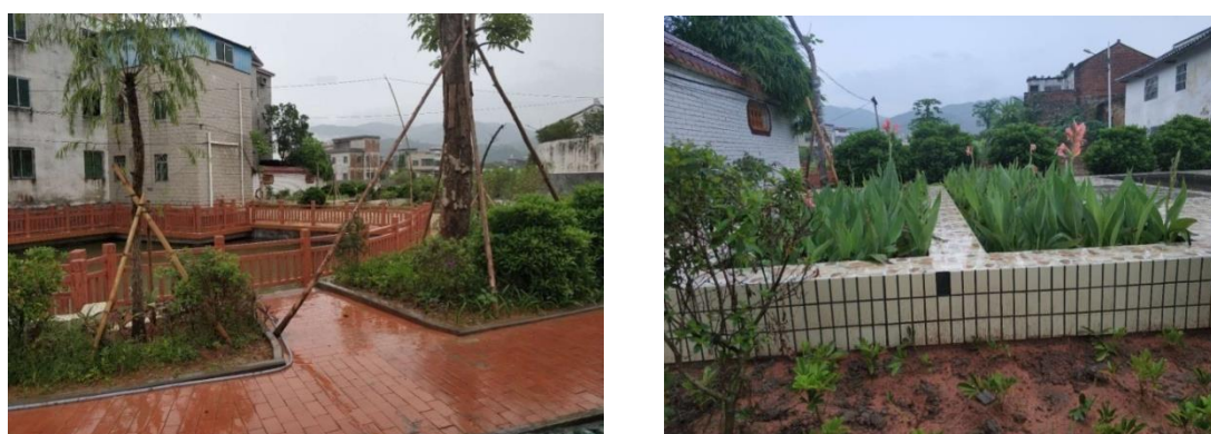
图 5-1 柳城村生活污水处理设施实景
