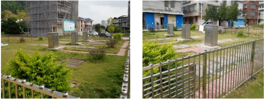
图 5-3 陂沟村生活污水处理设施实景
